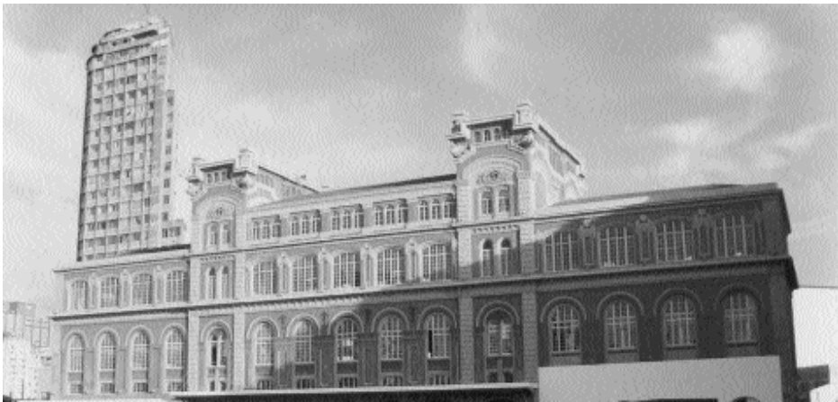
Ilustração n.º 1 – A primeira sede própria do DEOPS (1927), juntamente com todo o Gabinete de Investigações, estava localizada em um prédio na esquina das ruas dos Gusmões e Sta. Efigênia. Na fotografia, vê-se o prédio ocupado a partir de 1947 até a extinção da polícia política paulista (1983). Restaurado, o edifício é hoje ocupado pela Estação Pinacoteca.
